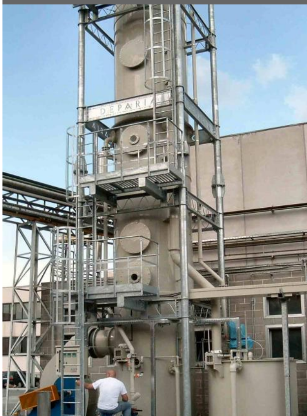
Colonna di assorbimento su emissioni da process rendering di sottoprodotti di macellazione (LIPOFOOD -TO-)
