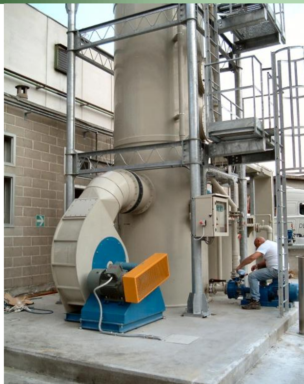
Anche i ventilatori sono normalmente realizzati in resine inattaccabili da sostanze chimicamente aggressive.
