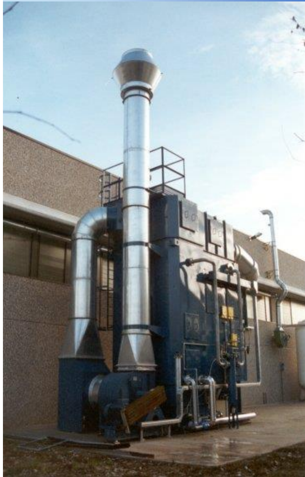
Depuratore K-IND II installato su emissioni da presse e forni di post-vulcanizzazione. (Parker Seals)
