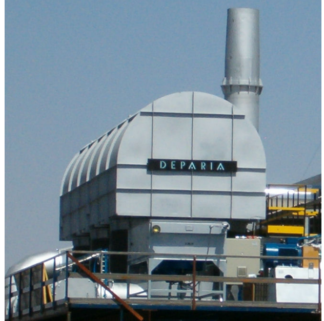
Figura 4 - Deparia Engineering progetta ed installa combustori su tutto il territorio europeo. Nell'immagine un combustore rigenerativo (RTO) a tre camere, installato su emissioni di un grande impianto per la produzione di lamiere di alluminio preverniciate (Alumasa S.A. - Badajoz - ES)
