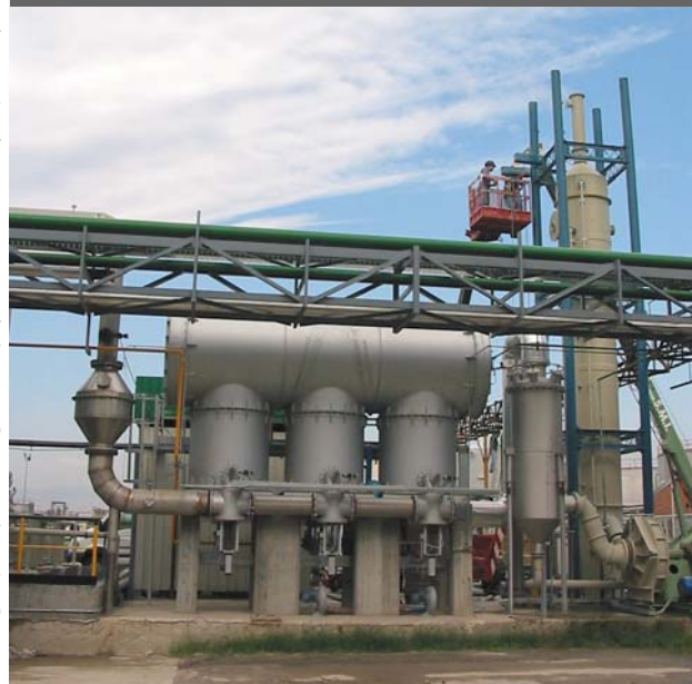
Impianto di abbattimento SOV composto da combustore rigenerativo tricamera, quench e colonna ad assorbimento (SOLCHEM -PV-) Sopra: rendering 3D; sotto: dal vero.
