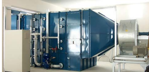
(in alto) Installazione di un depuratore M-91 in esecuzione speciale (con scrubber orizzontale) su emissioni da forni di post-curing; in secondo piano a sin. un K-IND installato su emissioni di stampaggio guarnizioni. (in basso) M91 installato. (Dowty O-rings — Malta)
